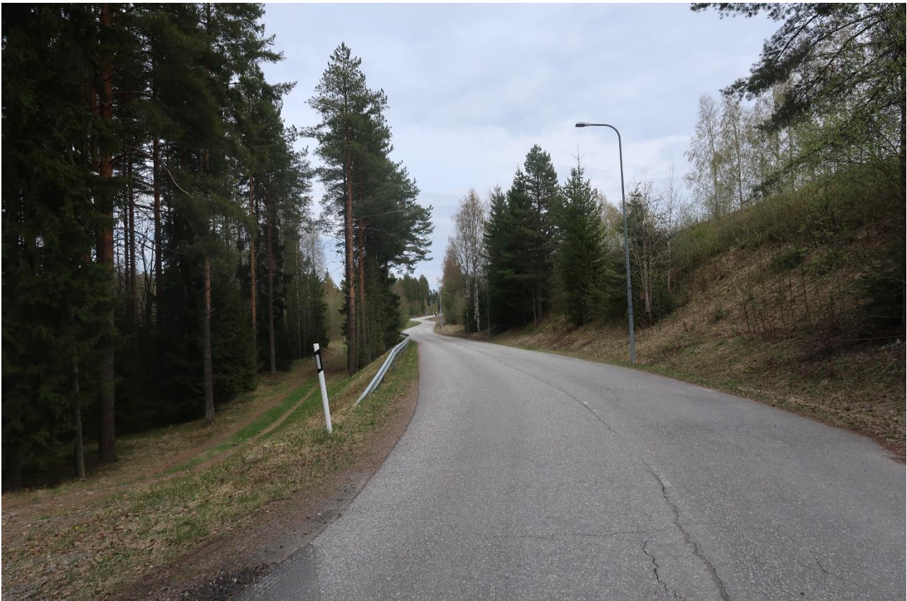
Kuva 17. Suvikkaantie lähivirkistysalueen kohdalla.
